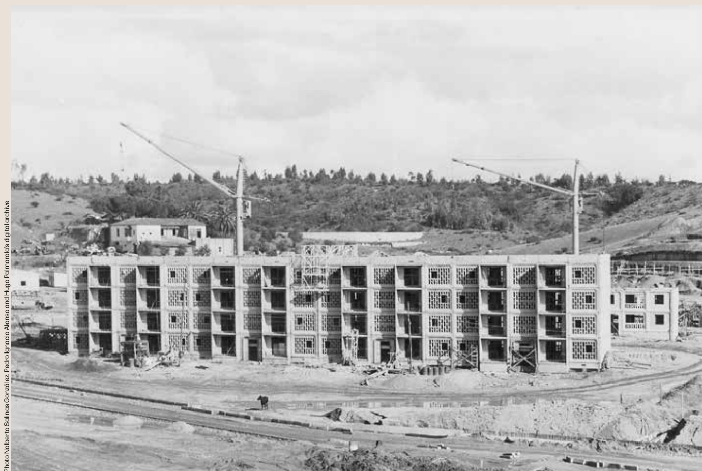
A sinistra: edificio residenziale costruito con il sistema (sovietico) di pannelli I-464. Gli architetti cubani introdussero dei pergolati di protezione dal sole per adattare il sistema al loro Paese. Pagina a fronte, dall'alto: la Koda House, che si può ordinare sul sito dello studio estone Kudasema OÜ nella versione di legno o di cemento; fotogramma dal film Good Bye Lenin! , regia di Wolfgang Becker, 2003
